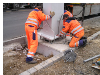
Aufstellung vormontierte Schilderbrücke unter Vollsperrung der BAB
