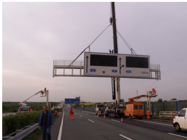
Aufstellung vormontierte Schilderbrücke unter Vollsperrung der BAB
